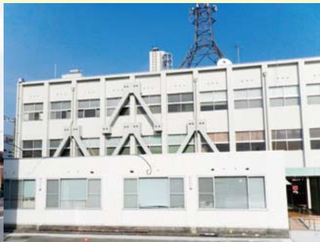
和歌山県日高総合庁舎(南面)PCブレース工法
