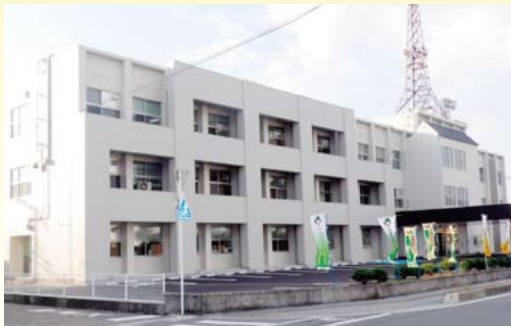
和歌山県日高総合庁舎(北面)PCアウトフレーム工法
