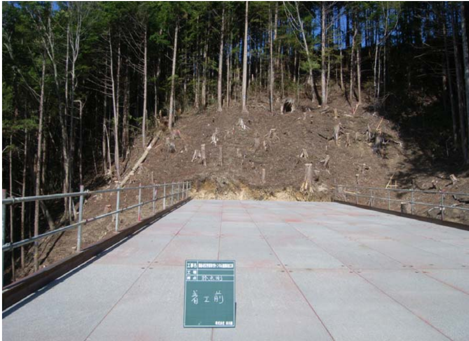
工事着手前の1号トンネル終点側(工事起点)の坑口
