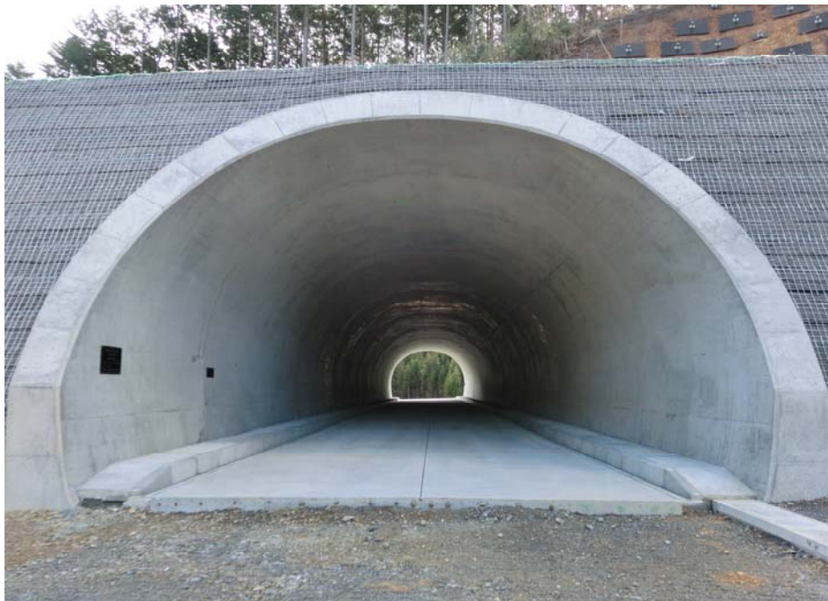
起点側坑口より
