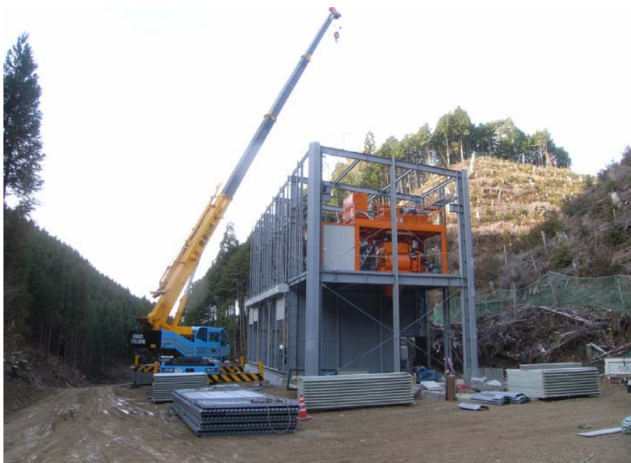
(上)生コンプラントの設置状況 (下)トンネル坑口前の暗渠管設置状況
