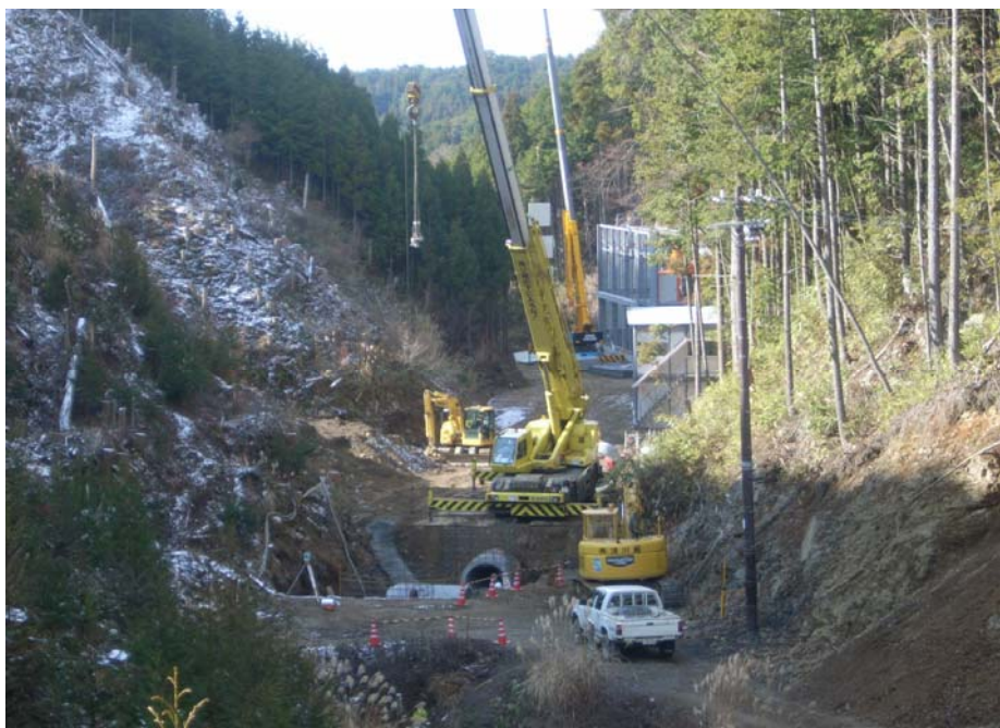
(上)生コンプラントの設置状況 (下)トンネル坑口前の暗渠管設置状況
