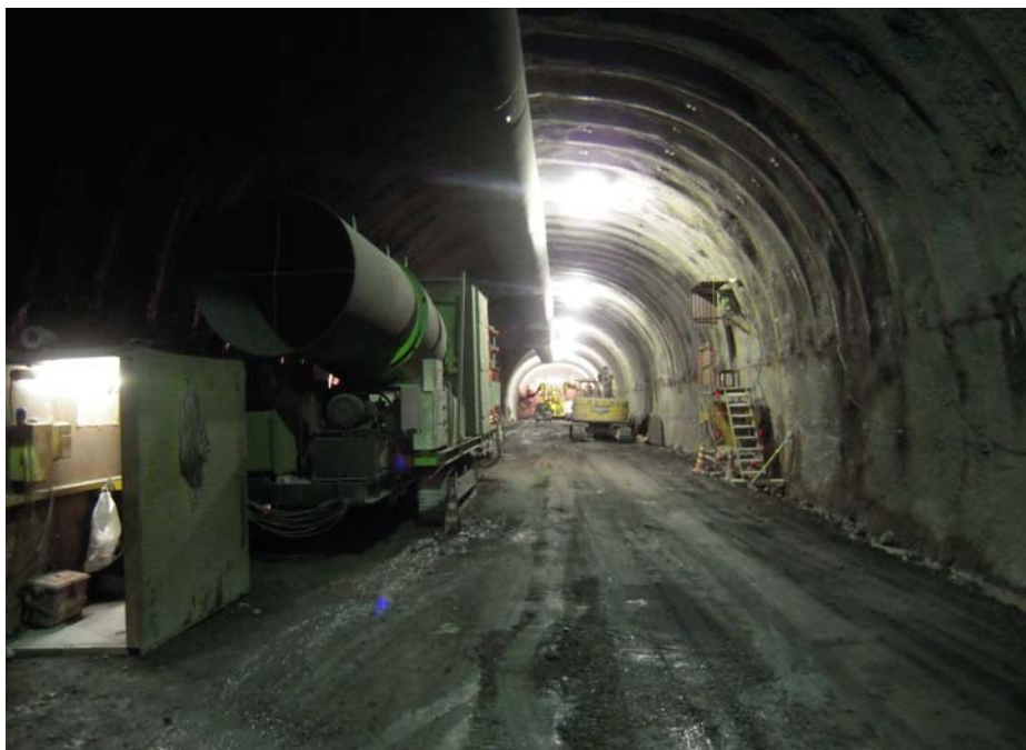
掘削区間。100mほど奥に切羽があります。
