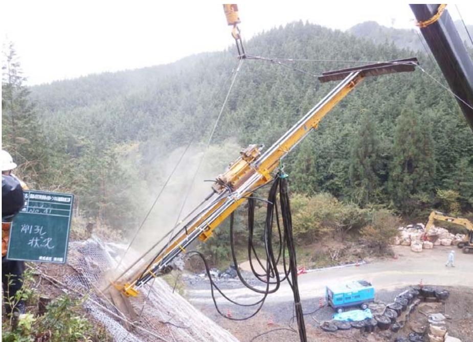
クレーンにて削孔機を吊り下げながらの施工です。
