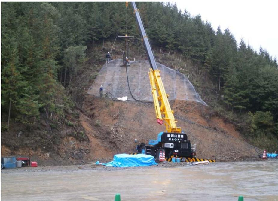
起点側トンネル上部の切土が完了して、補強土壁工の鉄筋挿入をしています。
